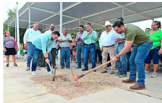
Construcción de domo col las Palmas
