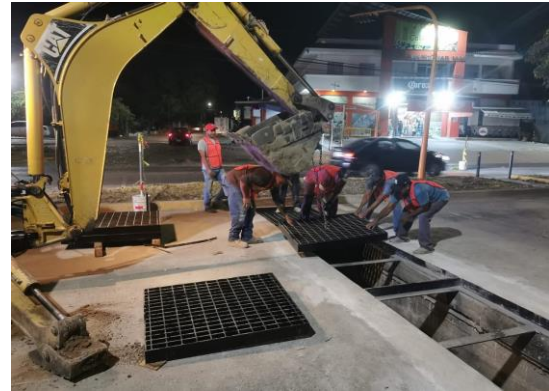
Rehabilitación de bocas de tormenta Av. México
