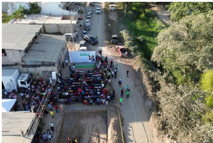
pavimentación calle Federación la calma
