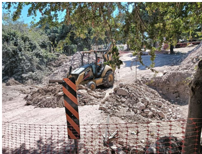
Construcción de Puente en calle Colon.
